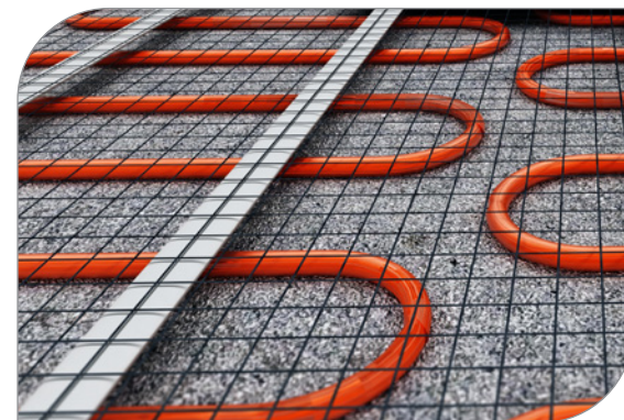
podlahové topení | underfloor heating
